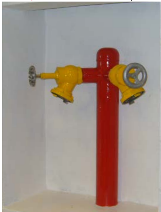
Figura 8 - Hidrante de recalque
