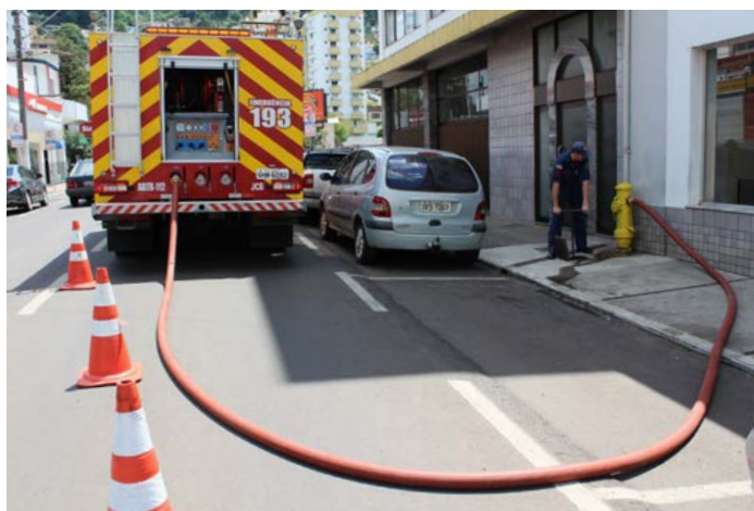
Figura 2 - Sistema de hidrante público
