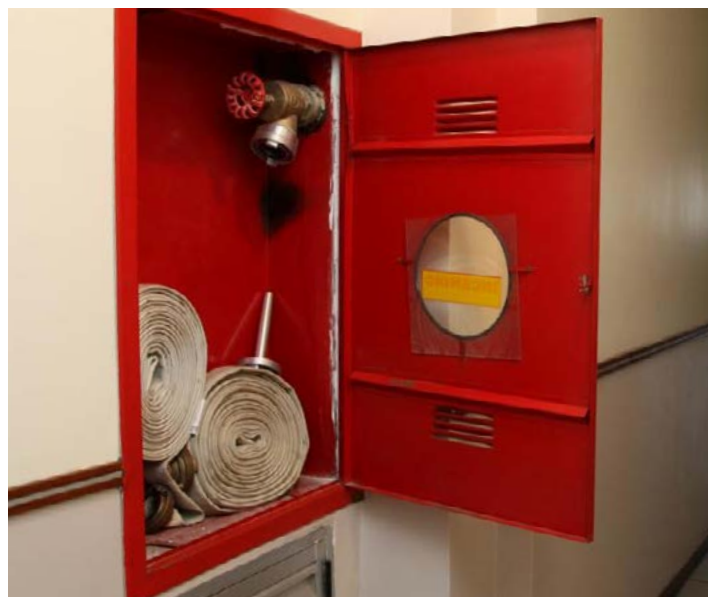
Figura 7 - Hidrante de parede
