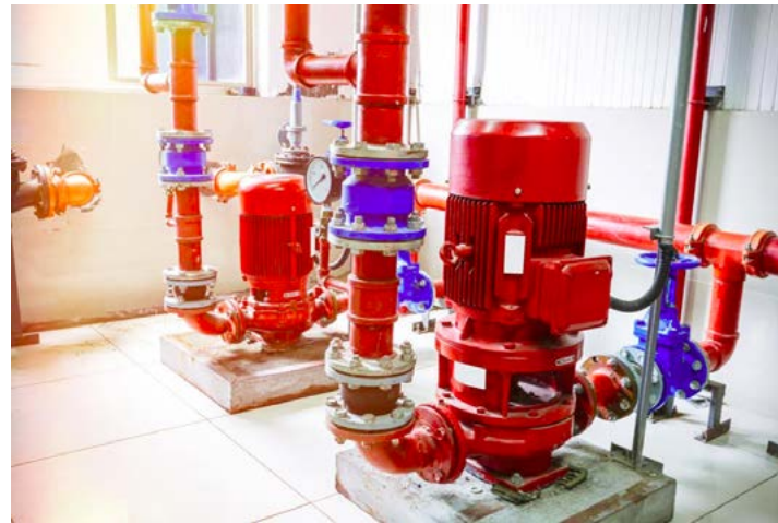
Figura 20 - Bomba hidráulica fixa
